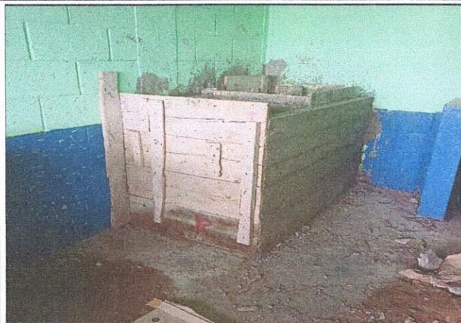
Foto 1: construcción de pila tanque de agua
