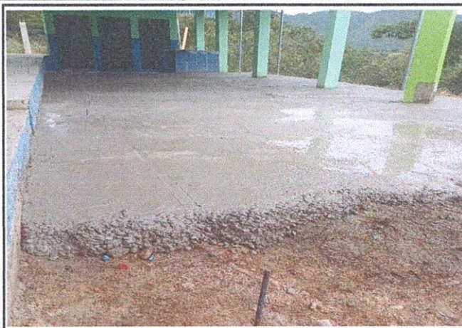
Foto 2: mejoramiento el ingreso a los sanitarios
